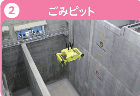
2 ごみピット 一時的に約7日分(2,500m 3 :500t)のごみをためる場所です。ごみは、燃えやすいようにごみクレーンを使ってよくかき混ぜてから、焼却炉に運びます。
